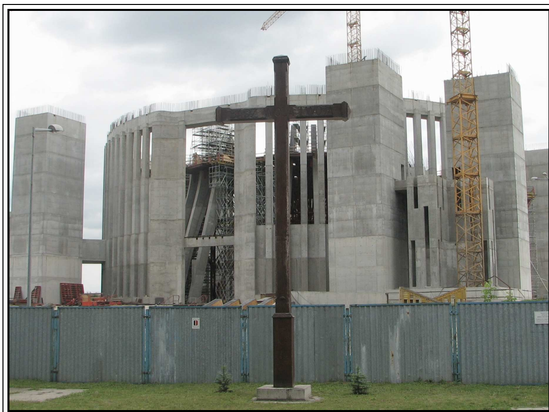
Budowa Świątyni Bożej Opatrzności w Warszawie
